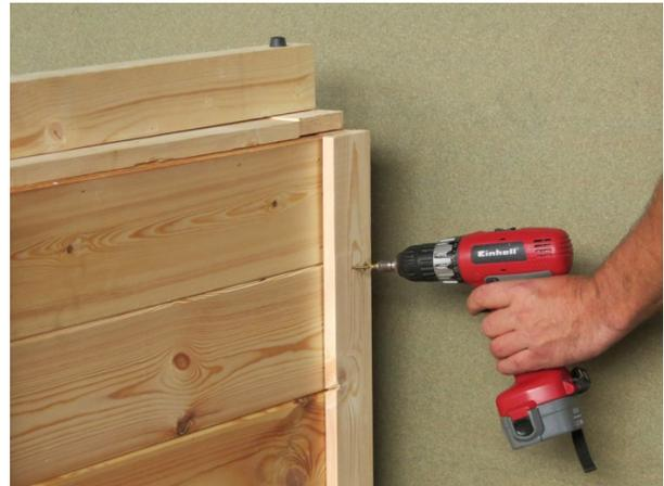
montieren Sie die Deckbretter an den Kanten verwenden Sie die 40 mm Schrauben, je 2 Schrauben pro Brett.
