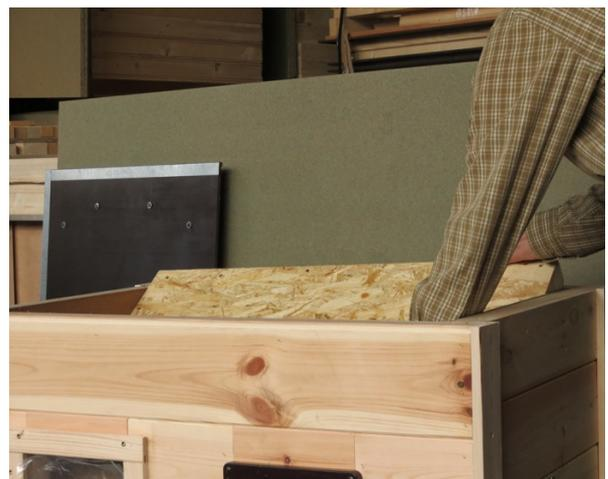
Legen Sie die mitgelieferten Leisten für die Dachneigung auf das Katzenhaus und verschrauben diese auf die Wandteile (60mm –Schrauben) lange Seite zwei Schrauben, kurze Seite zwei Schrauben.
